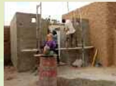
*Il a fallu revoir les toitures, créer des ouvertures, refaire des chapes en béton, créer des sanitaires et les raccorder à une fosse ...*
